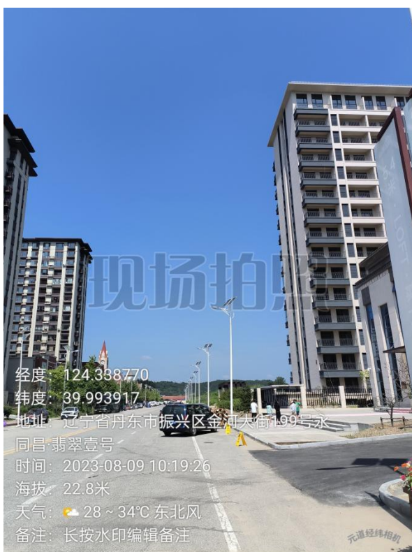
富晟国际小区西侧文详路
